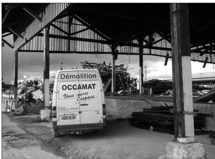
Halle Cardinet en démolition
